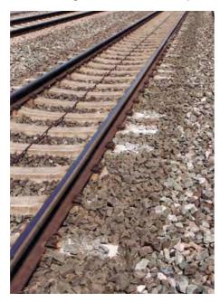
"White spots" signalisieren unterschiedliche Auflagerverhältnisse und Hohllagen unter den Schwellen Bild: B. Lechner, Prüfamt Verkehrswegebau
