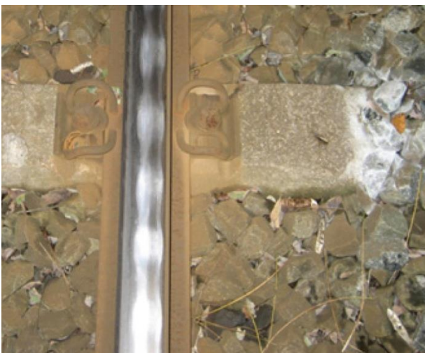
Abbildung 1: Riffelbildung entlang des Fahrspiegels[1]
